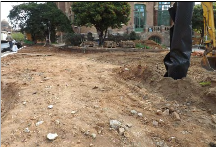
Vista del Sector 4 un cop realitzat el rebaix
