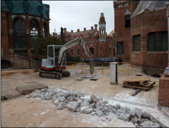
Vista general del segon tram del túnel 5 a l'inici de la intervenció
