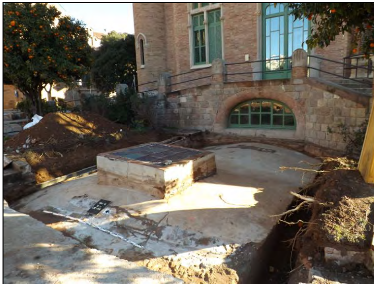
Vista general del primer tram del Túnel 3
