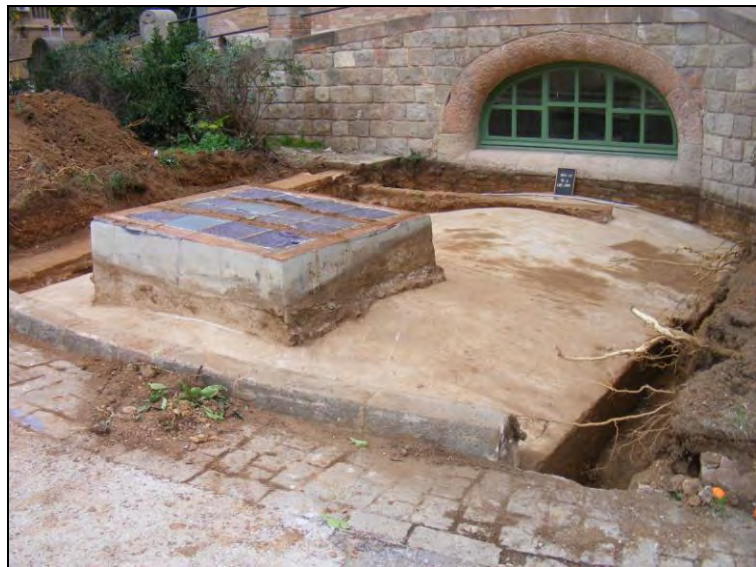
Vista de la volta del túnel u.e. 305
