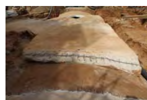
15 Túnel 7 Segona Fase
