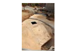
13 Túnel 7 Segona Fase
