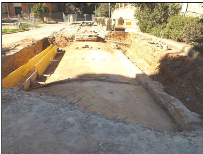
Vista del Túnel 4 des de l'Oest i vista des de l'Est un cop
