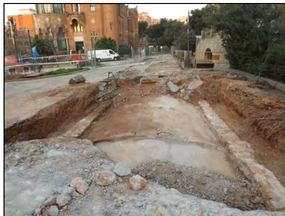
Vista del procés d'alliberament de la volta del túnel 4
