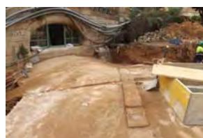
04 Túnel 7 Segona Fase
