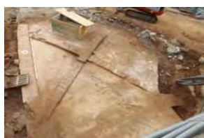
08 Túnel 7 Segona Fase
