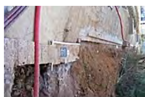
83) Vista general costat Sud.JPG
