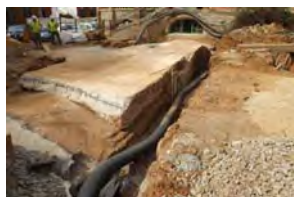
17 Túnel 7 Segona Fase
