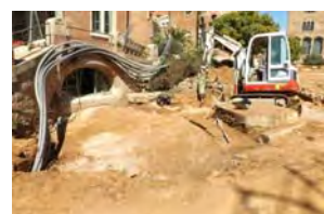
01 Túnel 7 Segona Fase
