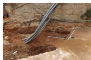
06 Túnel 7 Segona Fase
