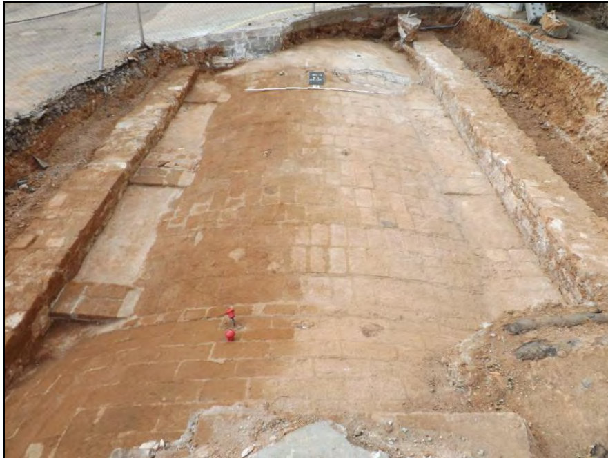
Vista del primer tram del túnel 4 pel costat Oest i on es veu al fons la part reparada del túnel
