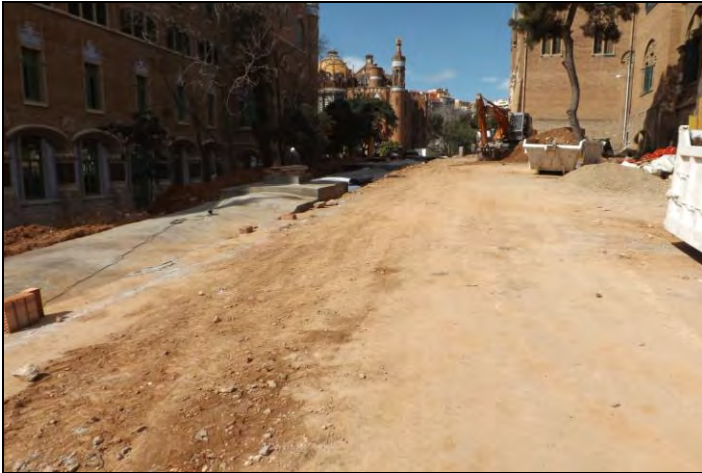
Vista general del Sector 1
