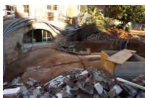
03 Túnel 7 Segona Fase
