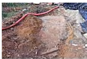
02) Inici Tram 1 (2).JPG
