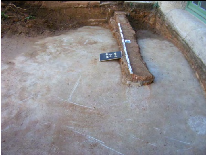
Vista de la filada de maons sobre la volta del túnel
