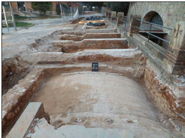
Dues vistes dels murets de maons que havien de fonamentar l'escala monumental
