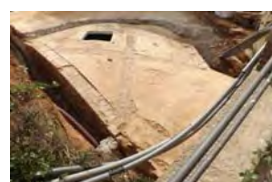
11 Túnel 7 Segona Fase
