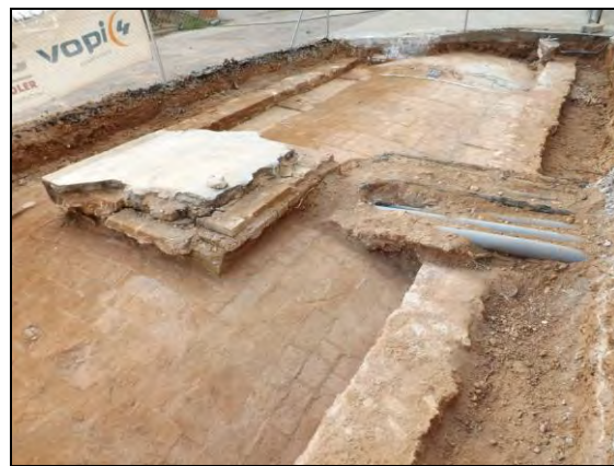
A l'esquerra una de les sabates dels fanals i a la dreta el cablejat que afecta la volta
