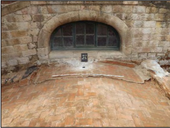
Dues vistes de la reparació u.e. 611 de la volta amb la tela asfàltica i el recreixement
