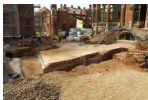
18 Túnel 7 Segona Fase
