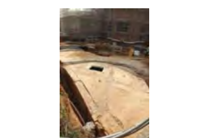
12 Túnel 7 Segona Fase
