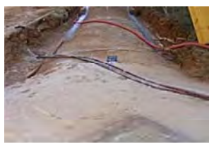
37) Vista general Tram 1.JPG
