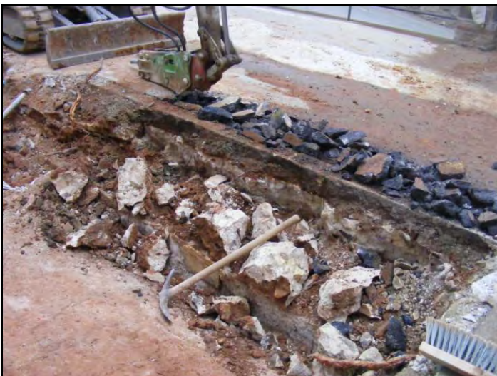
Vista del procés d'afectació de l'asfalt del Sector 2
