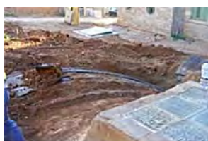
23) Inici Tram 3.JPG
