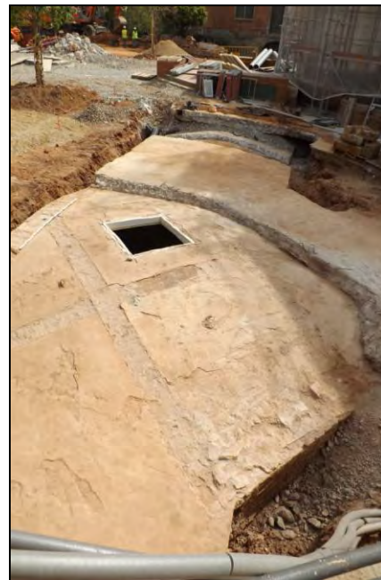
Dues vistes de la volta del túnel 7 un cop excavada
