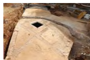
10 Túnel 7 Segona Fase
