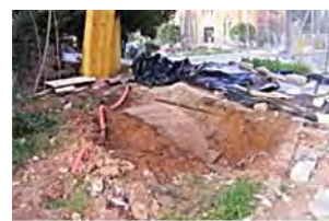
01) Inici Tram 1.JPG
