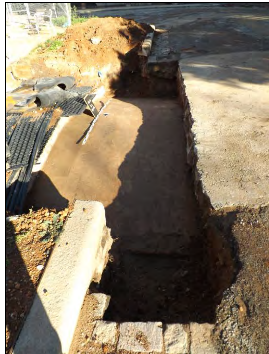
Dues vistes del segon tram del túnel 3 un cop documentat
