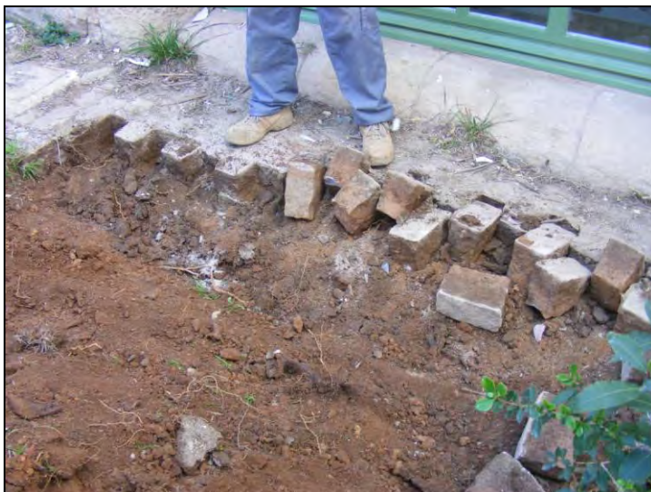
Extracció de les llambordes, la seva preparació i el nivell de terra
