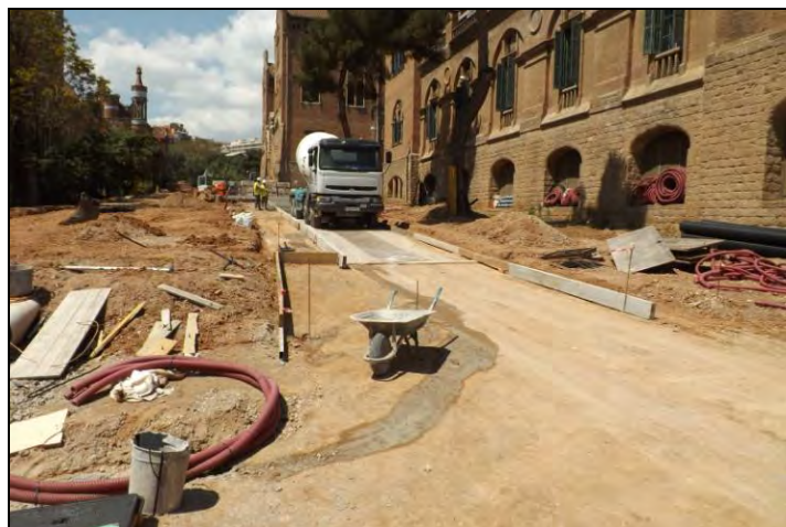
Vista del Sector 1 durant la seva urbanització
