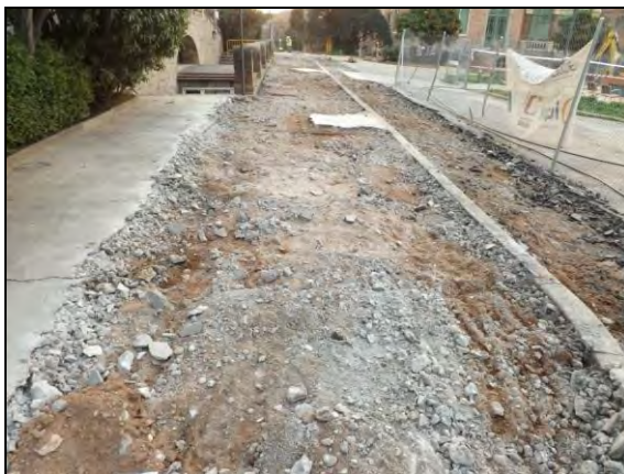
Vista del procés d'alliberament de la volta del túnel 4
