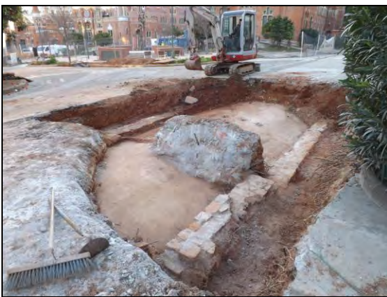
A l'esquerra una de les sabates dels fanals i a la dreta el cablejat que afecta la volta
