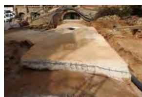
09 Túnel 7 Segona Fase
