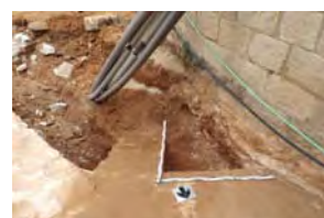
05 Túnel 7 Segona Fase
