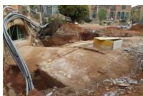
07 Túnel 7 Segona Fase
