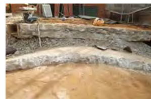
16 Túnel 7 Segona Fase
