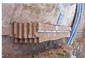
32) Muret Nord Tram 2.JPG
