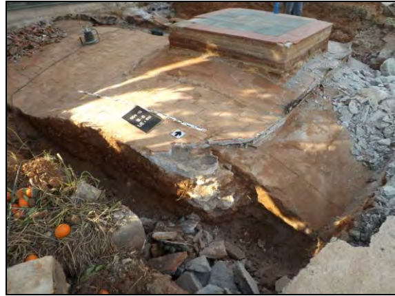
Dues vistes de la reparació u.e. 611 de la volta amb la tela asfàltica i el recreixement
