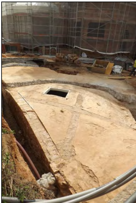
Dues vistes de la volta del túnel 7 un cop excavada
