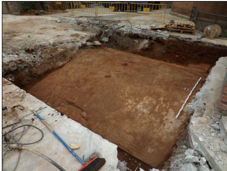
Imatge final del segon tram de la volta 5 un cop excavada
