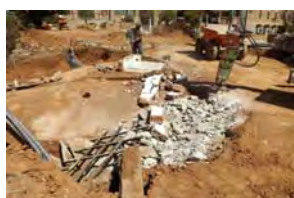
02 Túnel 7 Segona Fase
