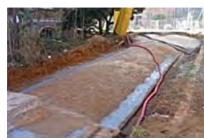
35) Vista general Tram 1.JPG
