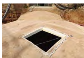
14 Túnel 7 Segona Fase
